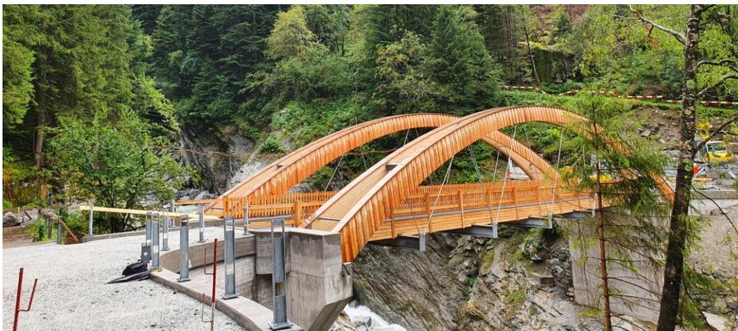
Seit 2017 ist das Bondasca-Tal aufgrund des Bergsturzes der Piz Cengalo geschlossen. Die Brücke wurde für die Durchfahrt von Lastwagen für Forstarbeiten konzipiert. Mit einer Länge von ca. 30 Metern und einer Breite von 4 Metern war der fehlende Platz die grösste Herausforderung. Die Bogenträger mussten für den Transport halbiert werden und dann mit einem Verschluss auf die Baustelle zusammengelegt werden.
